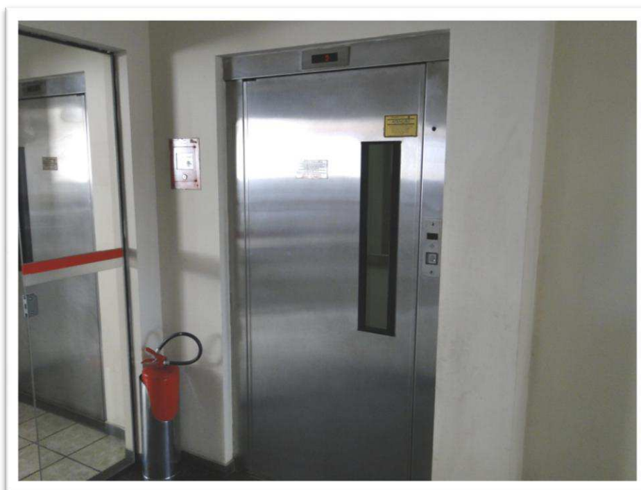
Foto nº 11 - Vista do elevador social nessa área social do “EDIFÍCIO FLAMINGO PARK”.
