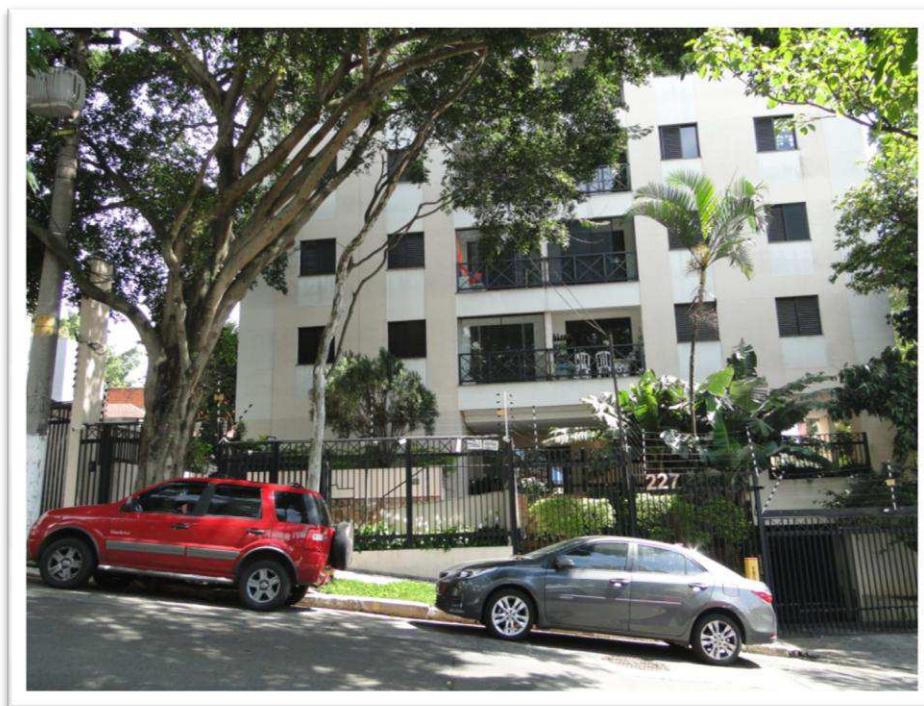
Foto nº 4 - Vista parcial da testada do “ EDIFÍCIO FLAMINGO PARK ” para a Rua Jaci.
