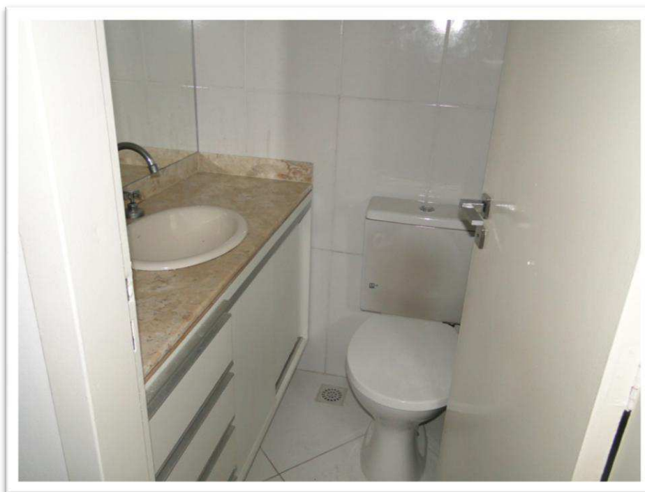
Foto nº 43 - Vista parcial do banheiro 2 (suíte), como denominado na planta baixa no ANEXO 2.
