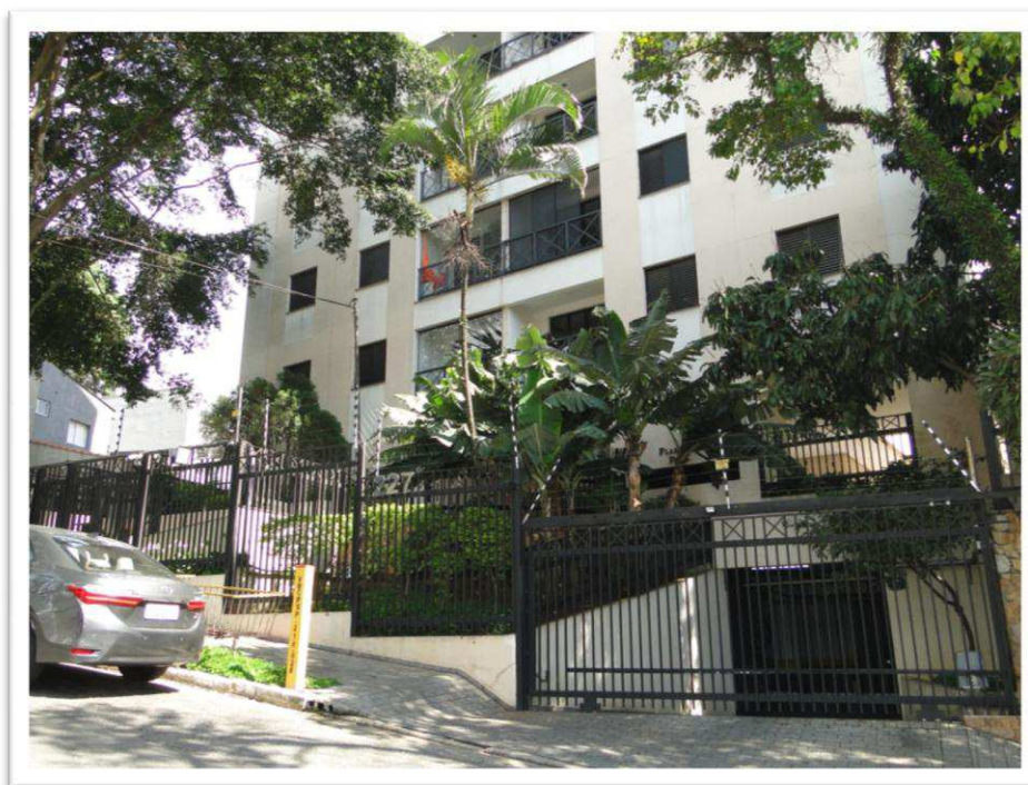
Foto nº 5 - Vista sob outro ângulo do “ EDIFÍCIO FLAMINGO PARK ”, podendo-se observar, à direita, a entrada do portão de acesso de veículos ao subsolo do prédio.
