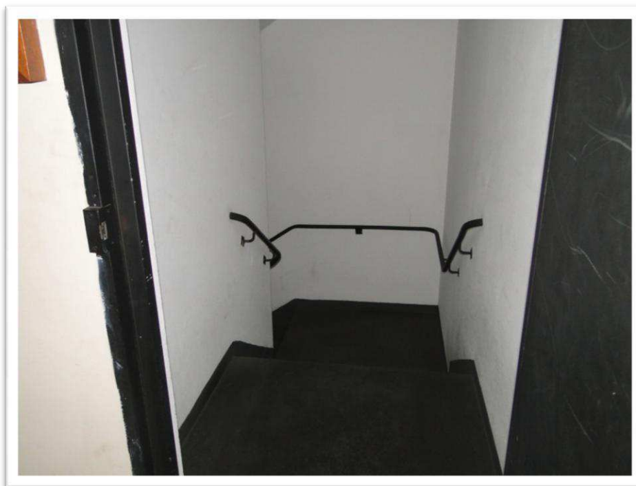
Foto nº 24 - Vista parcial da escadaria do prédio que é do tipo enclausurada com porta corta-fogo.
