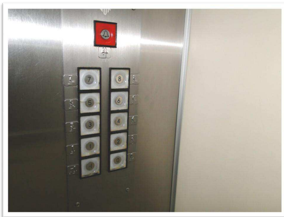
Foto nº 13 - Vista da botoeira no interior do elevador social que mostra que o prédio é constituído de subsolo, pavimento térreo e mais 8 (oito) andares.
