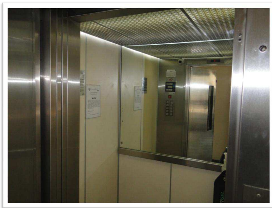
Foto nº 12 - Vista parcial interna do elevador social.
