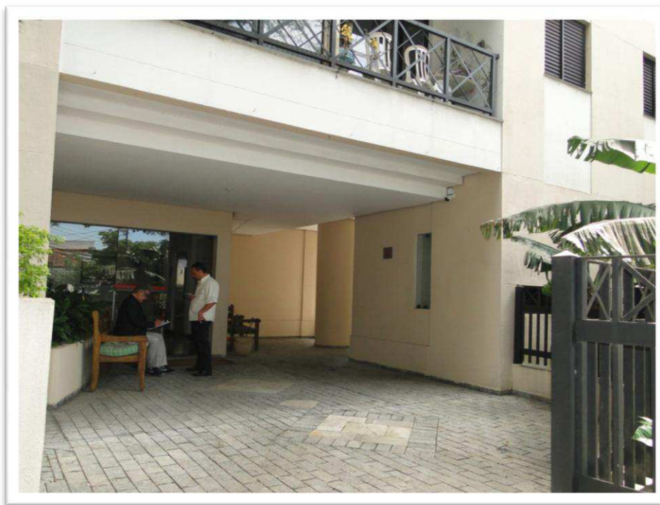
Foto nº 8 - Outra vista da portaria do prédio e de sua entrada social, à esquerda.
