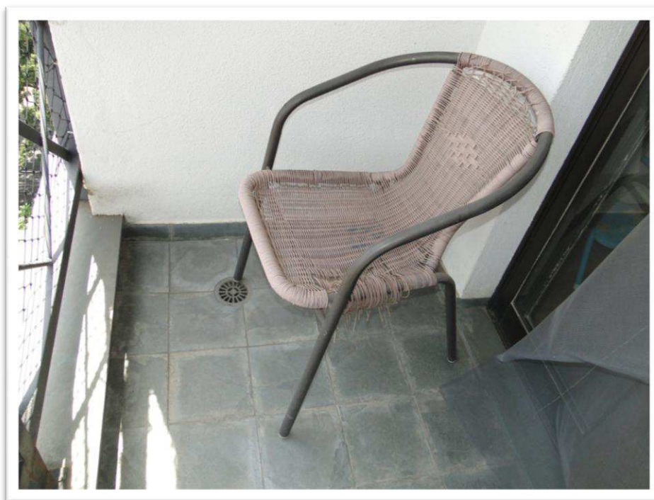
Foto nº 33 - Vista sob outro ângulo do terraço, com destaque para o piso de pedra ardósia.
