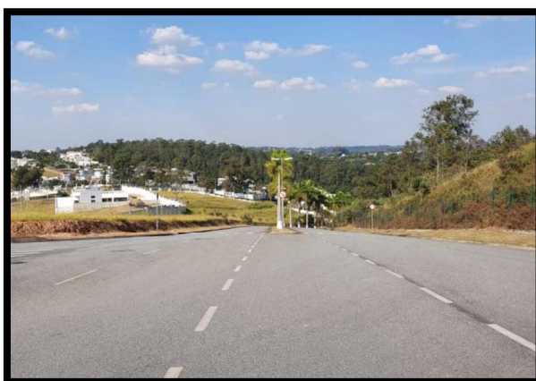
Ruas do condomínio
