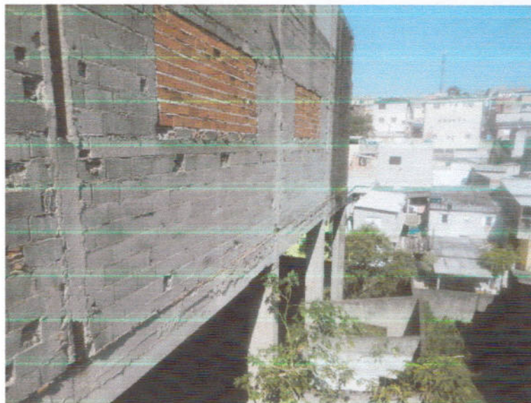
FOTO 7 – Aspecto geral da construção (galpão).
