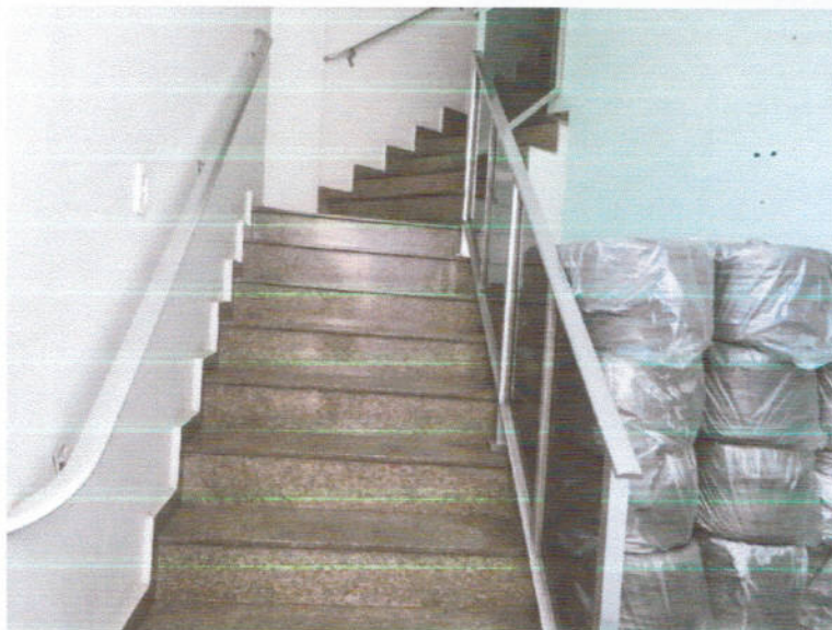
FOTO 7 – Escada de acesso para o pavimento superior (mezanino)
