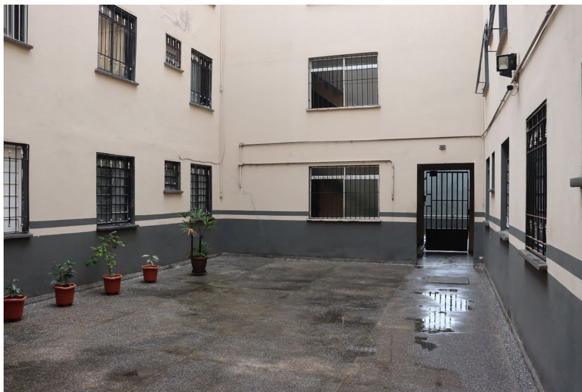
Foto 1 – Hall de entrada
