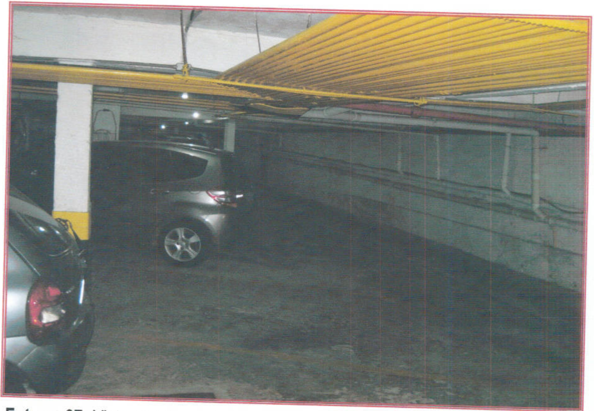
Foto nº 07: Vista geral do estacionamento localizado no pavimento térreo.
