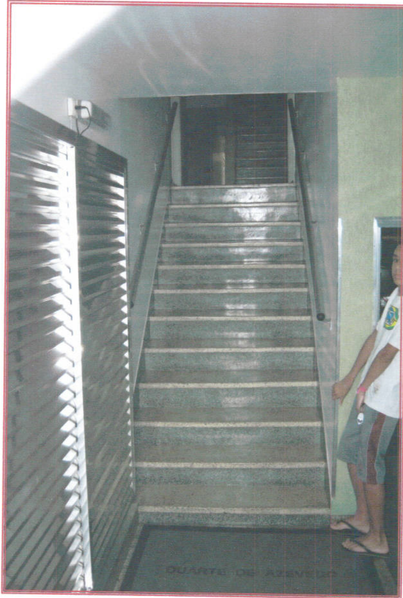
Foto n o 06: Vista do hall de entrada do edifício.
