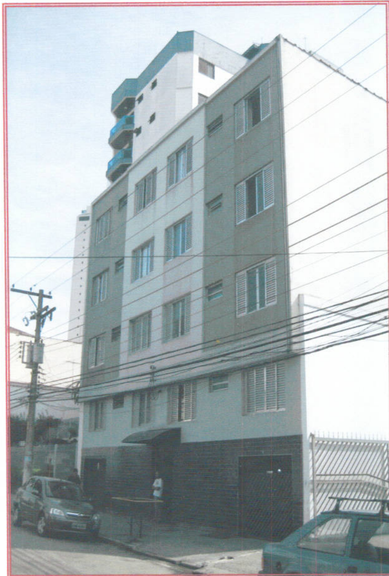
Foto nº 03: Vista geral da fachada do “Edifício Duarte de Azevedo”, onde se localiza o imóvel, objeto da avaliação, composto pelo apartamento nº 16, localizado no 1º andar.
