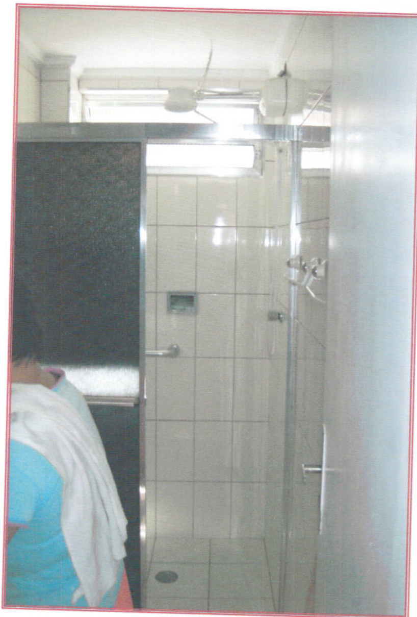
Foto n o 12: Vista geral do banheiro.
