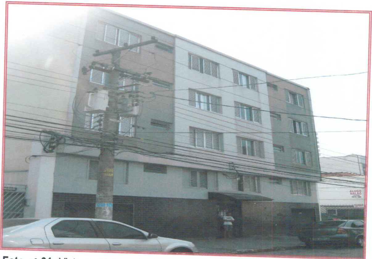
Foto nº 01: Vista geral da portaria de acesso ao Condomínio Edifício “Duarte de Azevedo”, onde se localiza o imóvel avaliando.
